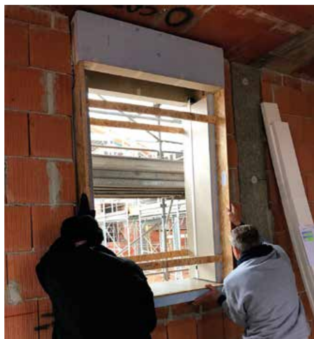
1. Inserimento monoblocco nel foro grezzo
