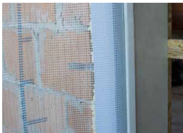
11. Dettaglio rete anti-fessurazione applicata esternamente
