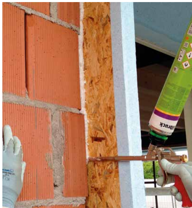
7. Applicazione schiuma per fissaggio su monoblocco
