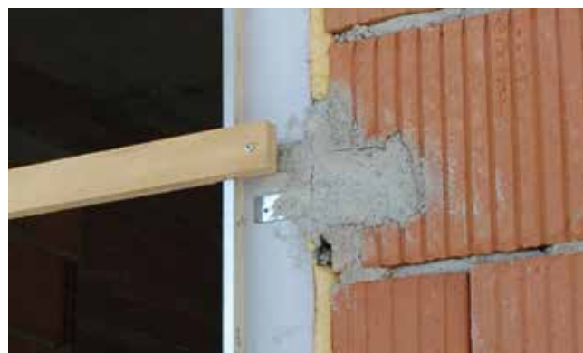
6. Riempimento spaccatura con malta cementizia
