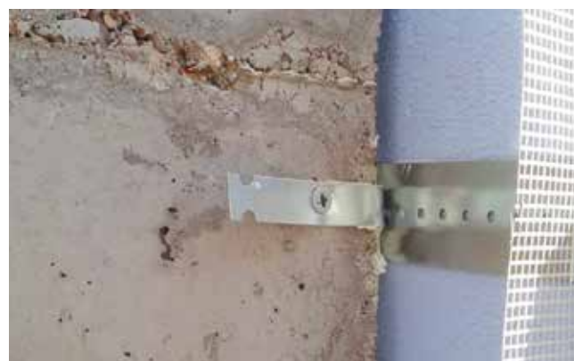
4. Fissaggio esterno con turbovite
