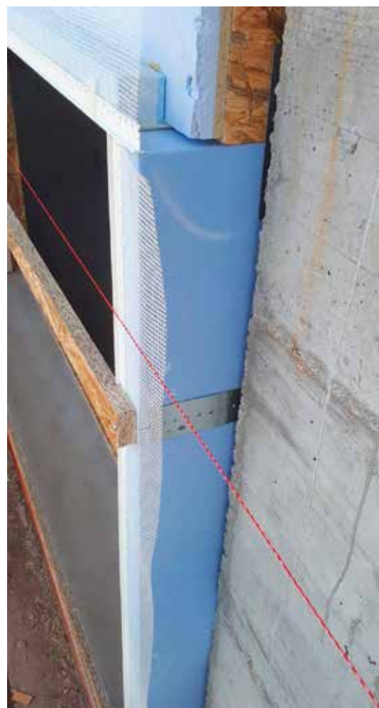
13. Lato interno posa rete anti-fessurazione
