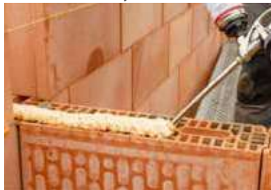
Incollaggio di pannelli e costruzione di pareti interne
