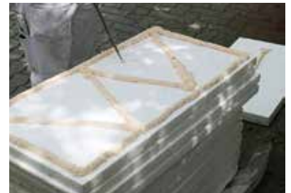
Incollaggio di pannelli isolanti in sistemi a cappotto ETICS/EIFS
