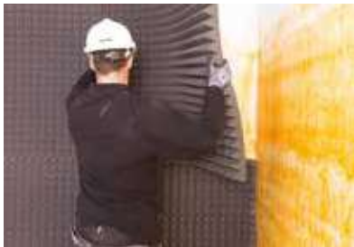
Incollaggio di isolamento su superfici lisce
